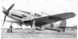
本機はドイツの液冷航空エンジンDB601 を国産化したエンジンを搭載した日本唯一の液冷エンジン戦闘機である。試作機は1941年に初飛行を行った。この時の陸軍の軽戦闘機一式戦隼が515km/h、重戦の二式戦でも580km/hの最高速度であった。しかし、この時飛燕のテスト機審査ではメッサーシュミットBf109Eの速度を30km/h上回る590km/hを発揮した。1942年秋、福生で「戦闘機研究会」という名称の比
